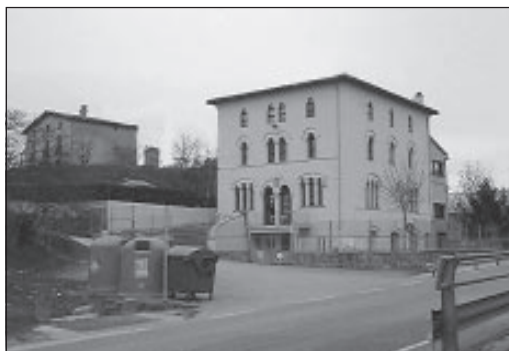
Edifici actual de Les Escoles
